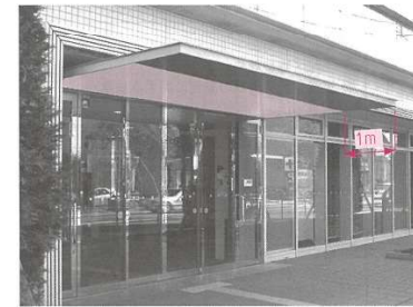
庇など建物から1m以上突き出ている場合は、先端から1m後退した部分が建築面積に算入されない。(03 面積と高さ)
